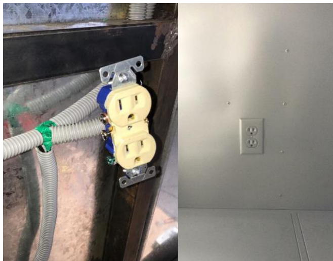
Figura 40 Tapado de acometidas
