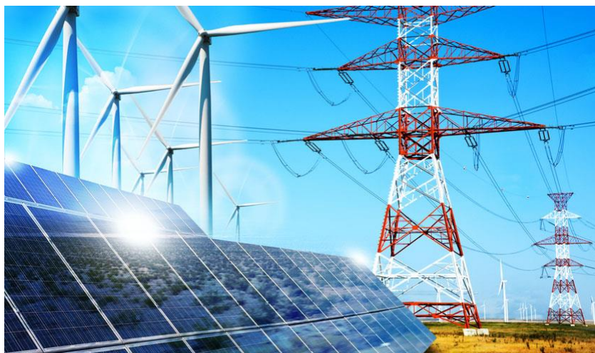
Figura 3 Instalaciones de transformación y distribución
