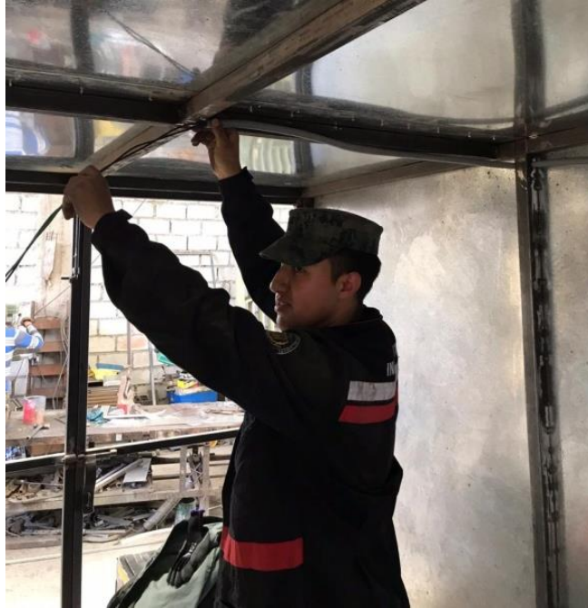
Figura 35 Cruce de cableado
