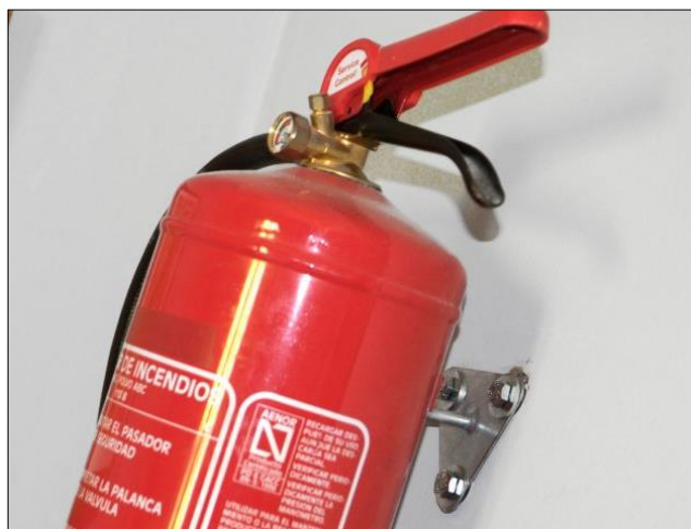
Figura 19 Instalación del soporte para extintor
