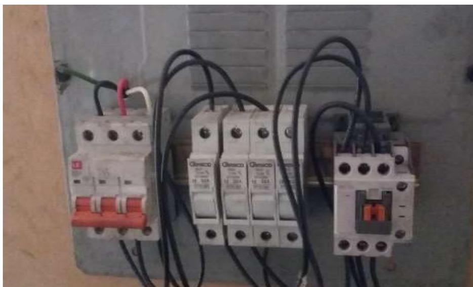
**Figura 17.** Contactor trifásico
