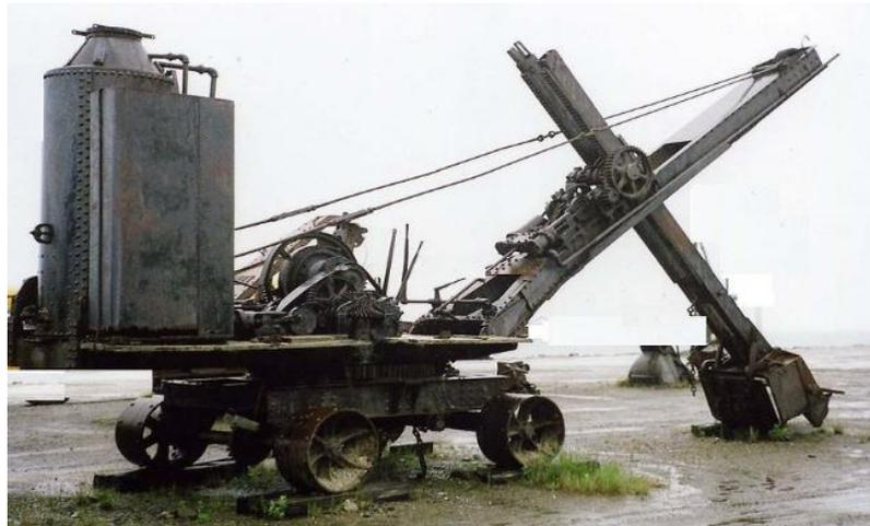
*Nota.* Se indica la primera draga mecánica y a vapor. Tomado de (Excavalandia, 2012)
