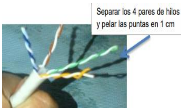
Figura 50. Preparación del cable UTP categoría 6
