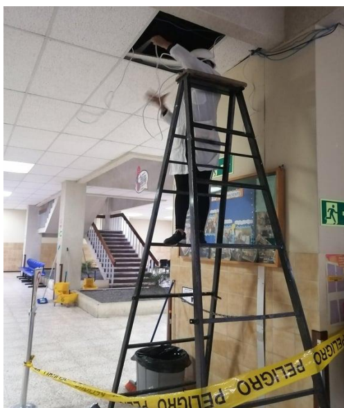
Figura 45. Equipo de medidas de seguridad
