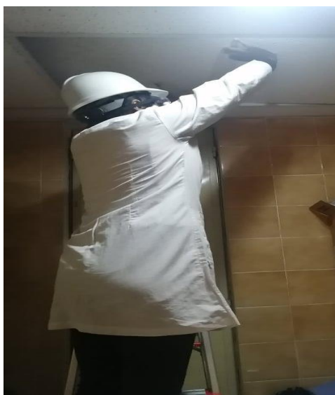
Figura 47. Tendido de cableado para 1 cámara
