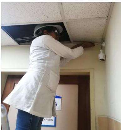
Figura 49. Perforación y fijación de cámara
