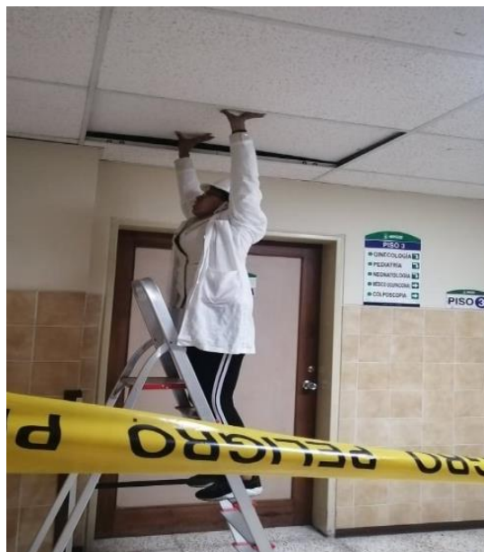
Figura 46. Tendido de cableado Piso 3
