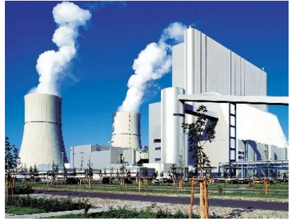
Figura 17. Agua de enfriamiento
