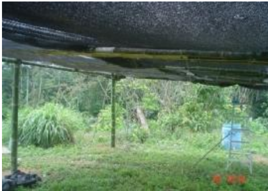
Figura 9. Estructura y cubierta del umbráculo.
