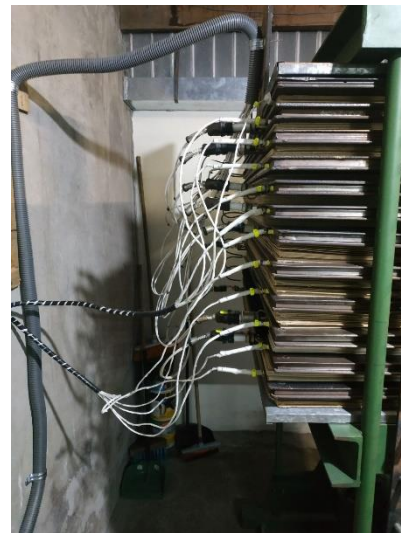
(b) Reemplazo de cableado de alimentación.
