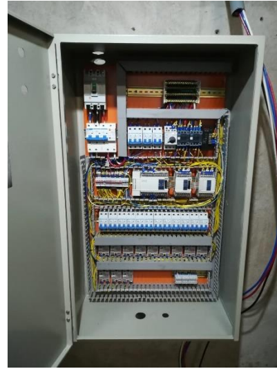
(b) Tablero armado colocado sobre gabinete
