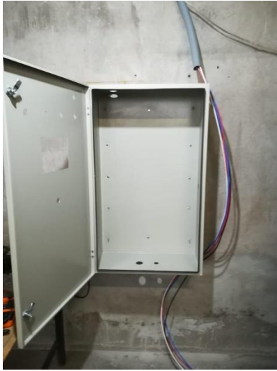
(a) Gabinete colocado en pared
