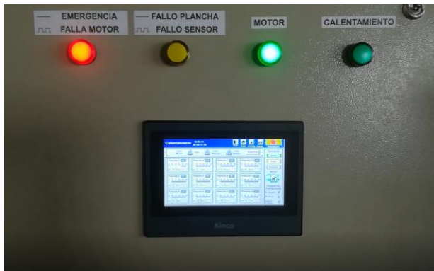
(d) Alarma de fallo de motor (Tren de pulsos).
