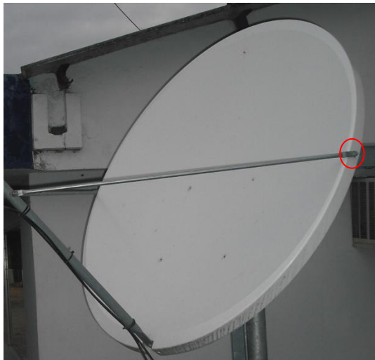
Figura 2.18 Soporte del ODU de la antena VSAT del Sistema Satelital Vsat de la Fuerza Aérea Ecuatoriana
