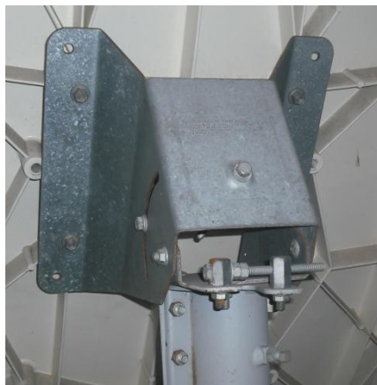
Figura 2.14 Montura de la antena VSAT del Sistema Satelital Vsat de la Fuerza Aérea Ecuatoriana
