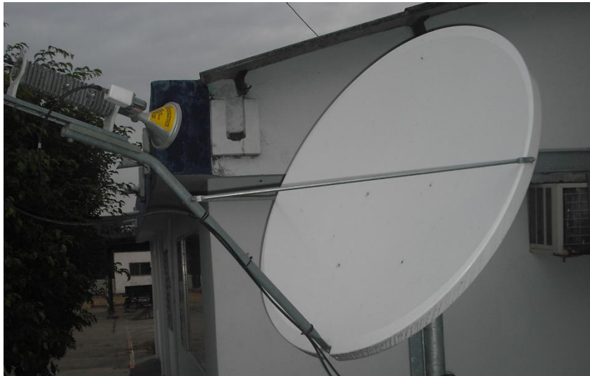
Figura 2.19 ODU y Plato de Antena armados de la antena VSAT del Sistema Satelital Vsat de la Fuerza Aérea Ecuatoriana
