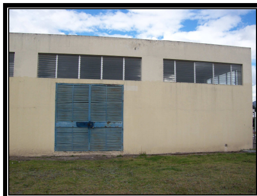
Foto 6.2: Instalación alejada del instituto Fuente: Laboratorio de Control Industrial Realizado por: Cbos. Sánchez Luis
