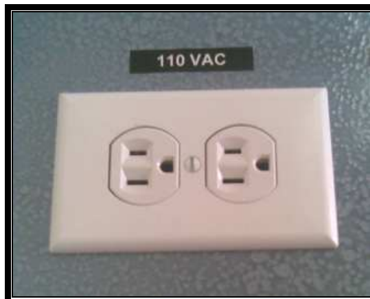
Foto 6.31: Toma de 110V Fuente: Laboratorio de Control Industrial Realizado por: Cbos. Sánchez Luis
