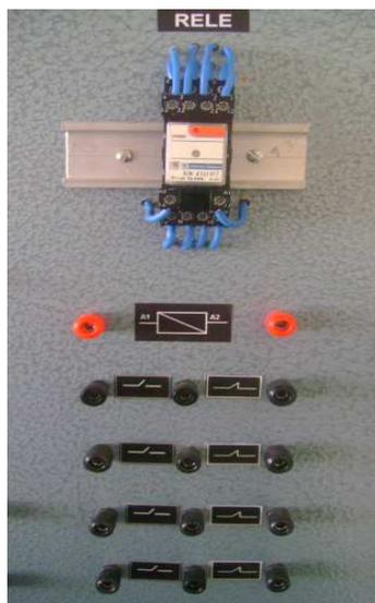
**Foto 6.18** Colocación de Relé (Parte frontal)
