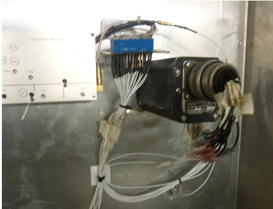
Fotografía 3.13 Conexión de Cables entre el Control VHF y el VIR-30
