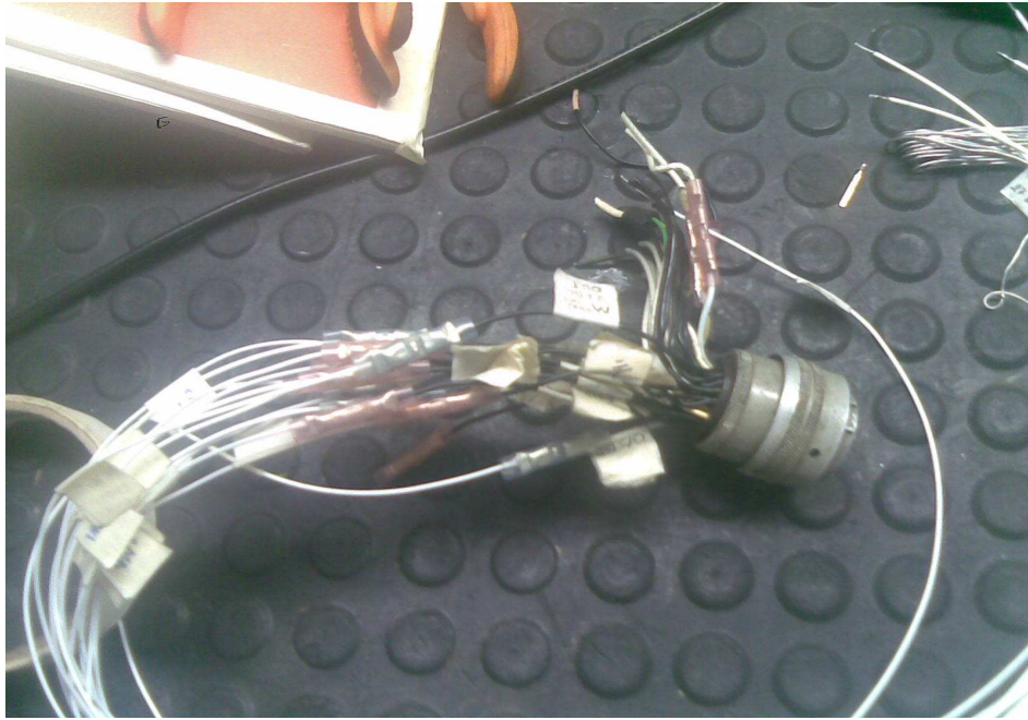
Fotografía 3.10 Conector del Control VHF 313-4D
