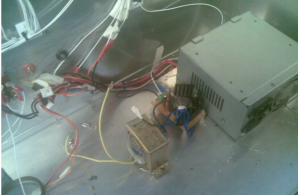
Fotografía 3.3 Instalación de las fuentes de alimentación en el Banco Didáctico.
