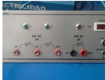
Foto.3.30 Cambio de borneras.
