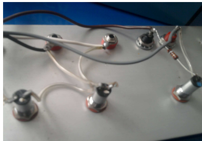
Foto.3.29 Cambio de borneras.
