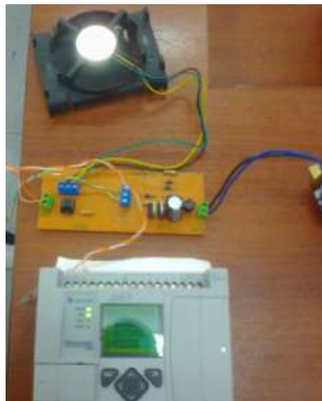
Fotografía 3.6: Conexiones y pruebas preliminares entre ventilador y PLC MicroLogix 1100. Elaborado por: Díaz Gamboa Marco Antonio.
