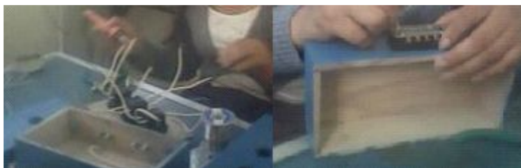
Figura 123: Conexiones eléctricas de borneras
