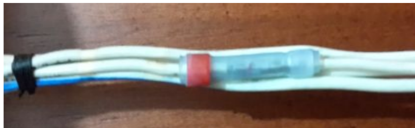
Figura 27: Colocación de la manga de sellado
