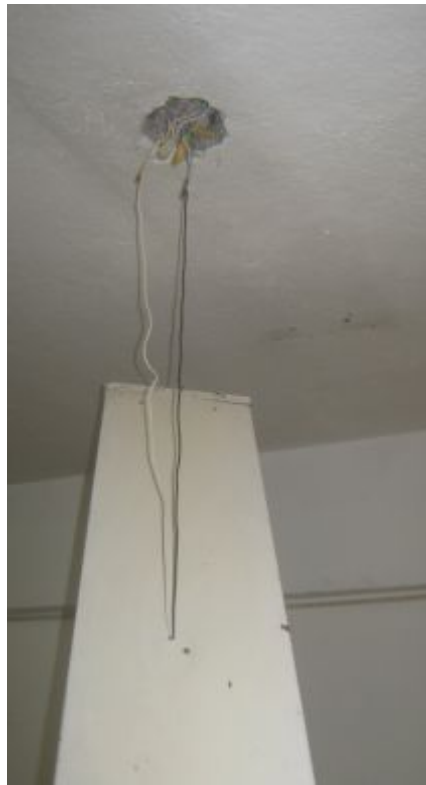
Foto 8: Desmontaje de la luminaria.
