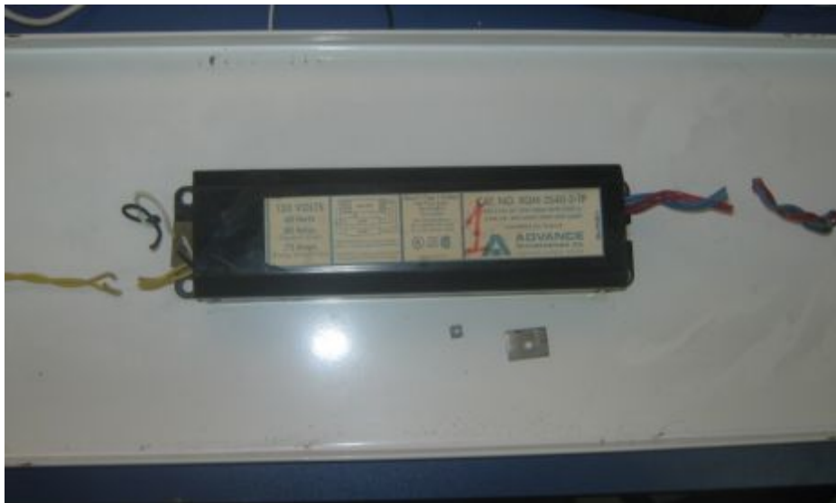
Foto 9: Retiro del balastro.
