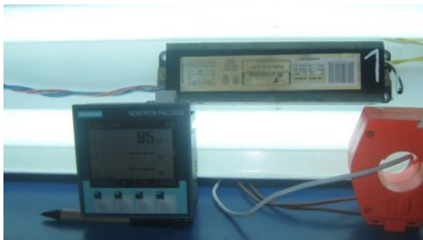
Foto 1 : Medición de Potencia eléctrica.
