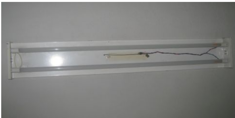
Foto 12: Colocación de las lámparas LED.
