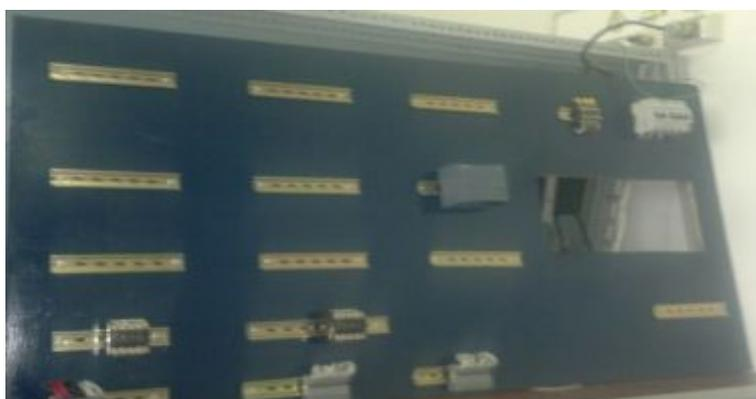
Foto 2: Colocación de rieles din
