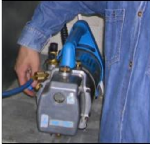
Figura 6.3 Encendido de la bomba de vacío
