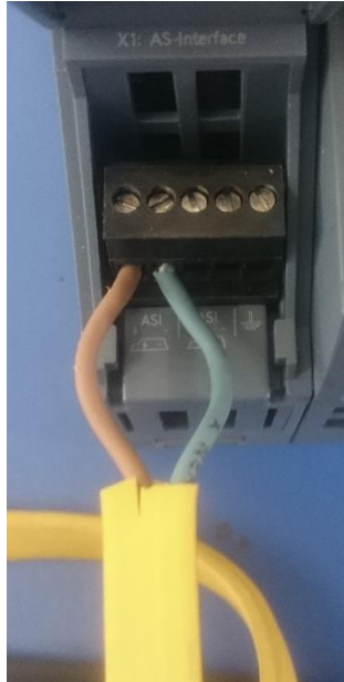
Figura 29 Cableado finalizado al maestro CM 1243-2.
