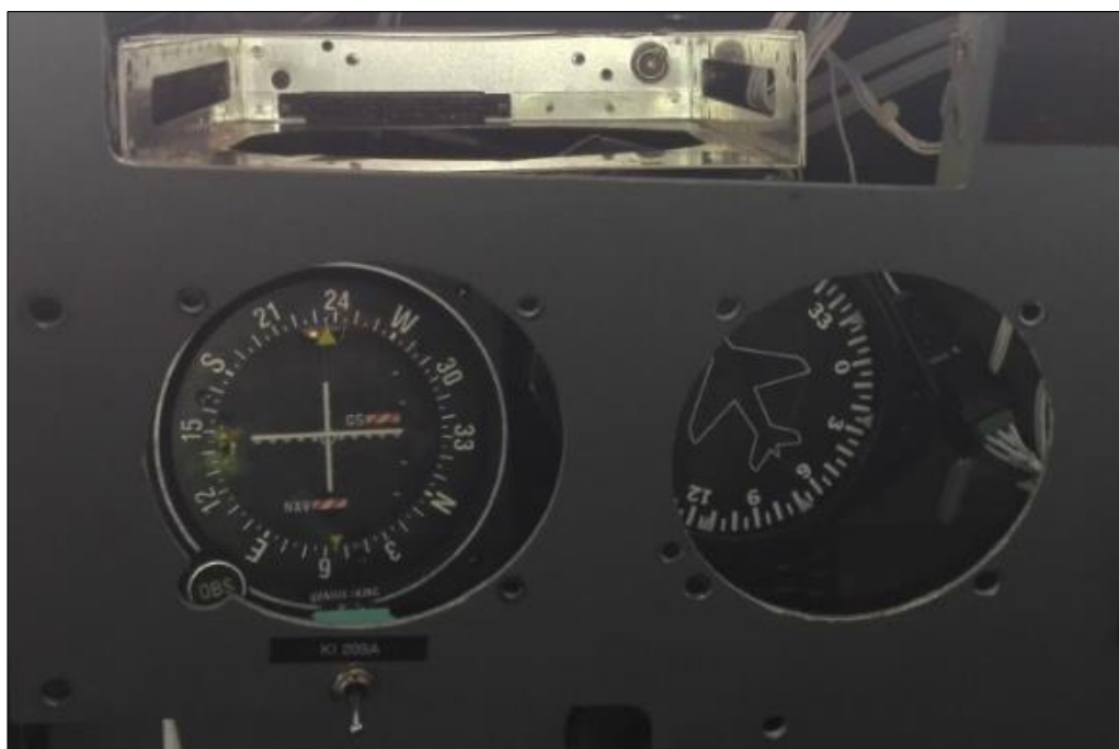
Figura 72 Instalación del instrumento en el panel de la aeronave.
