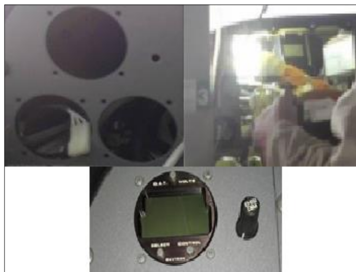
Figura 24 Análisis, verificación e instalación del instrumento en el panel de la aeronave CESSNA T206H.
