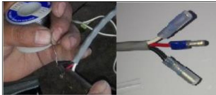
Figura 22 Colocación de terminales para luces y sensores ubicados en el TIP TANK.
