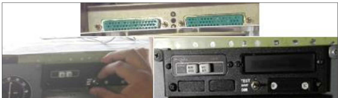
Figura 45 Verificación e instalación del equipo AUDIO PANEL dentro de la cabina de la aeronave.
