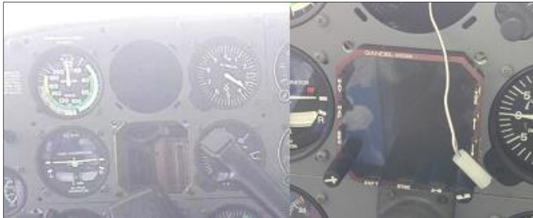
Figura 86 Instalación del instrumento en el panel de la aeronave.
