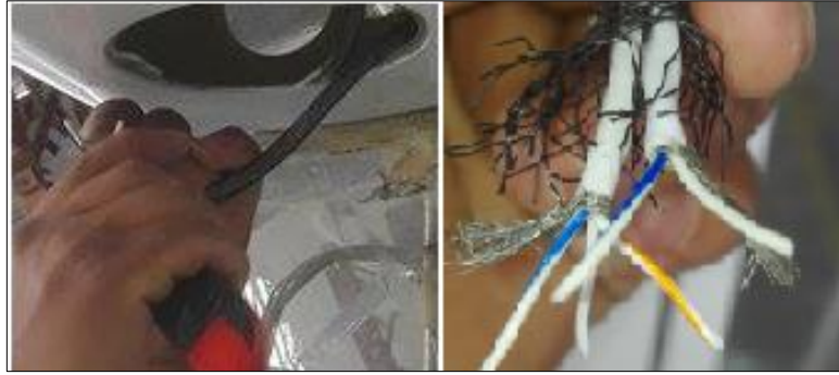
Figura 21 Reparación de cables dañados.
