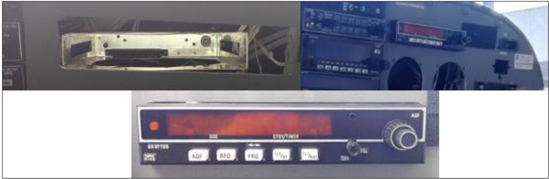
Figura 78 Reconocimiento del conector e instalación del equipo ADF en el panel de la aeronave.
