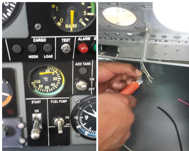
Figura 20: Instalación y verificación de elementos electromecánicos (interruptores simples, dobles y triple).
