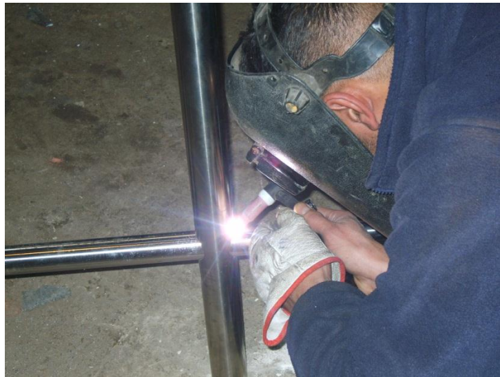
Figura 12 Elaboración de la estructura del modulo
