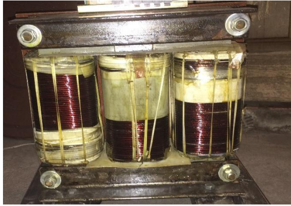
Figura 20 Armado del autotransformador
