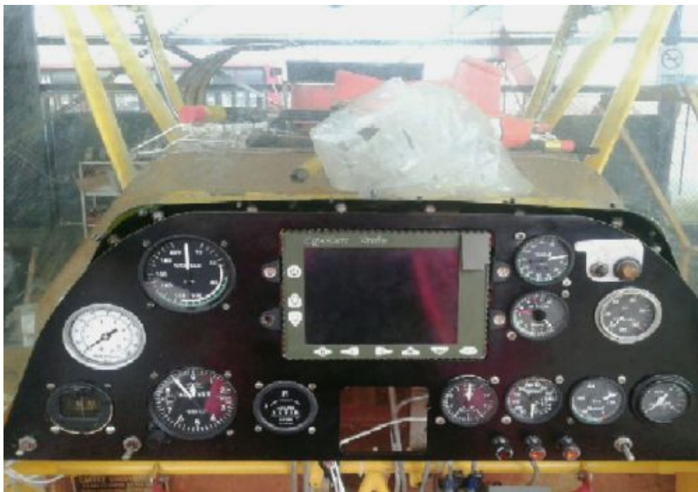
Figura 23: Instalación Del Main Panel
