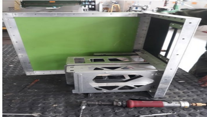
Figura 23. Ensamblaje base de los equipos.
