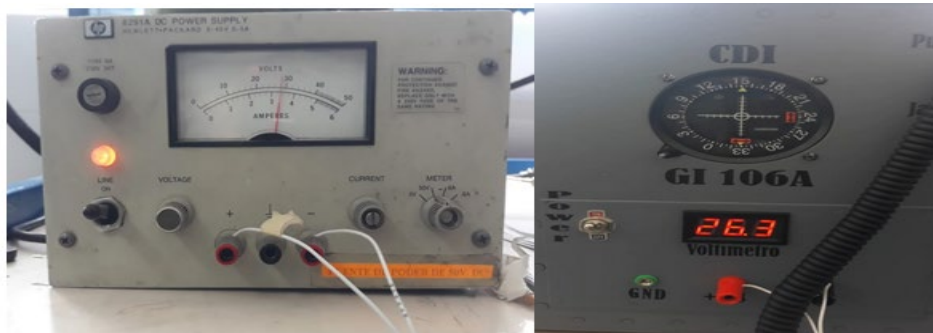
Figura 43. Encendido de la fuente y verificación del voltaje en el banco.
