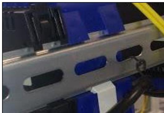
Nota: El gráfico muestra el carril Din instalado como soporte de elementos. Tomado de Martín, 2019.
