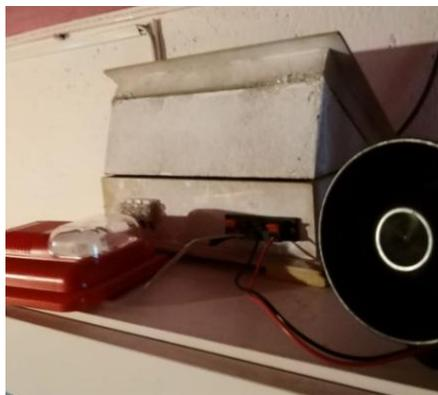
*Nota:* La figura muestra el uso de borneras para facilitar la conexión de las sirenas.
