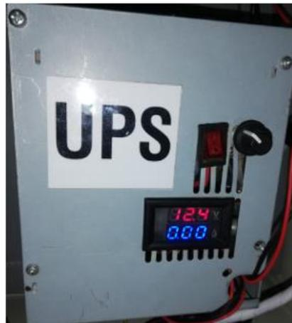
*Nota:* La figura muestra el voltaje de carga del batería utilizado en el UPS de DC.
