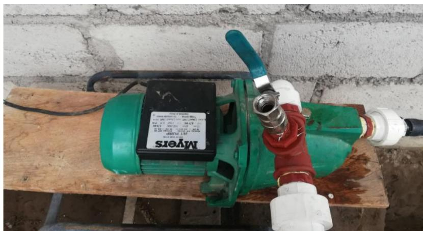
*Nota:* La figura muestra la electrobomba marca Myers de 1hp.
