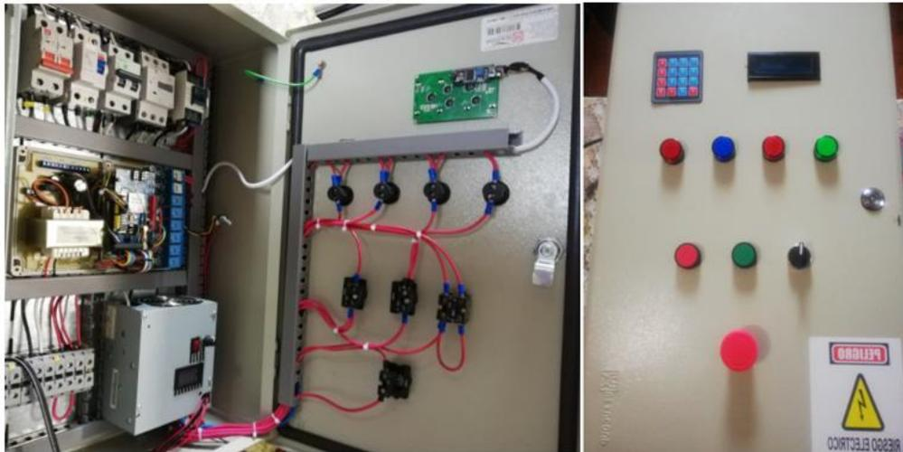
*Nota:* La figura muestra el tablero de control con todos sus elementos ensamblados.
