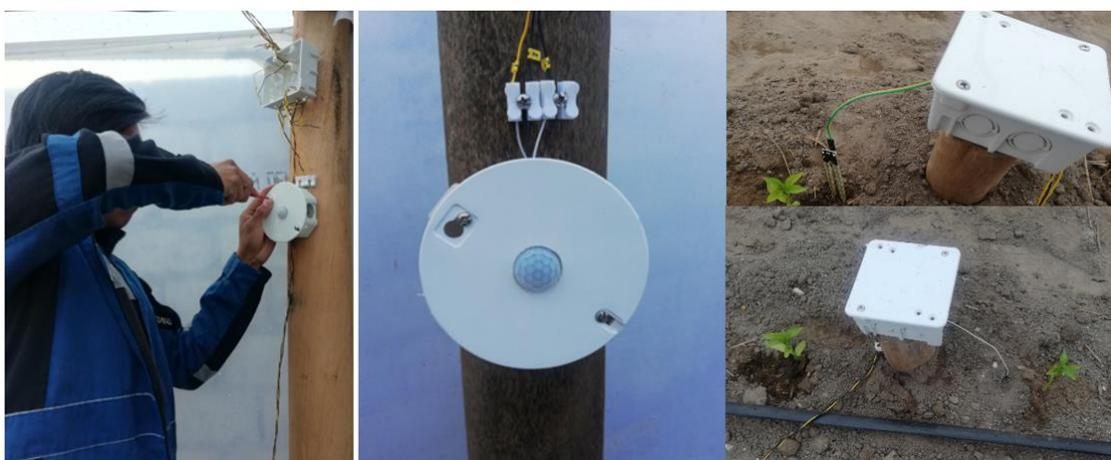
*Nota:* La figura muestra la instalación del sensor de movimiento PIR y el sensor de humedad de suelo utilizando como base un cajetín de plástico y una tapa ciega.
