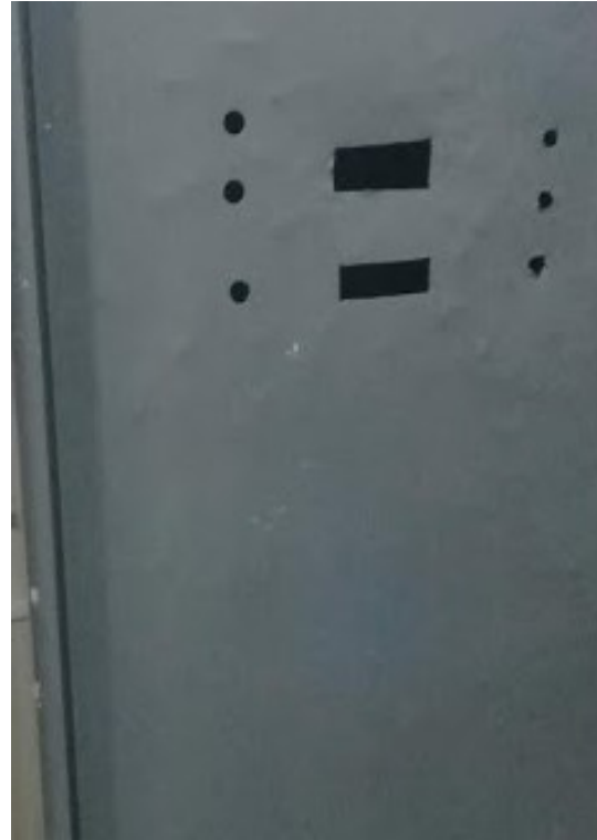
Pintado y Adecuación para Elementos
