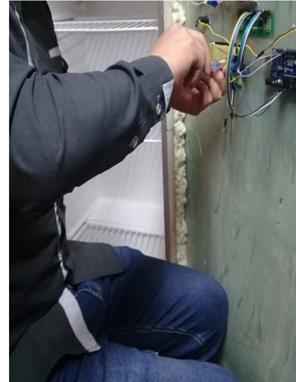
Implementación de circuitos de control
