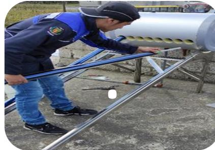
Colocación de tubos al vacío
