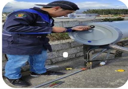
Conexión del sensor de nivel y temperatura
