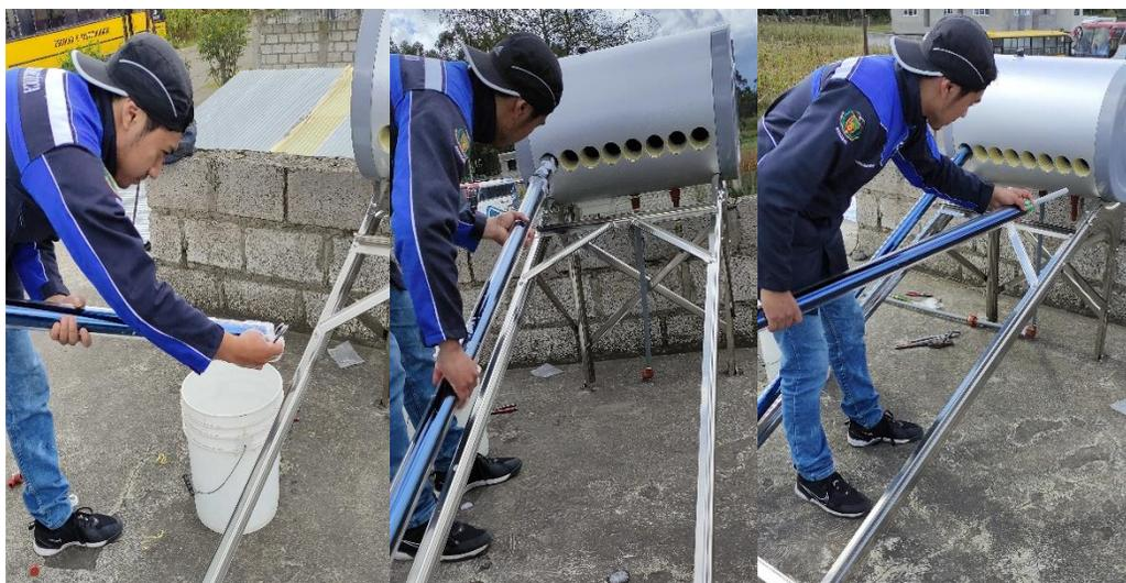
*Nota:* La fotografía muestra los pasos ejecutados en la colocación de los tubos al vacío en el termotanque.
