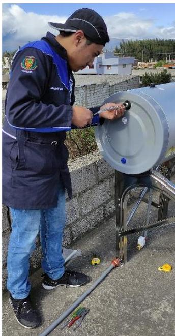
*Nota:* La fotografía muestra la conexión del sensor con el termotanque.
