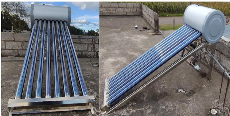
*Nota:* La fotografía muestra el prototipo de colector solar completamente ensamblado.
