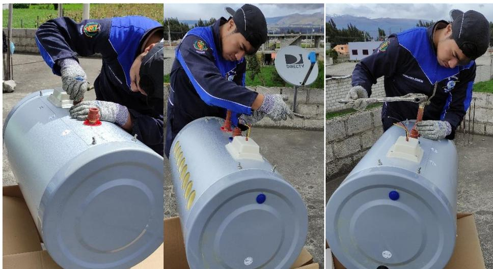
*Nota:* La fotografía muestra las conexiones de los accesorios de entrada y salida de agua.
