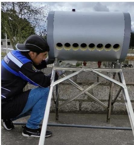
*Nota:* La fotografía muestra el montaje del termotanque en la estructura.
