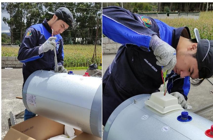
*Nota:* La fotografía muestra el proceso de inserción y fijado de la resistencia eléctrica en el termotanque.
