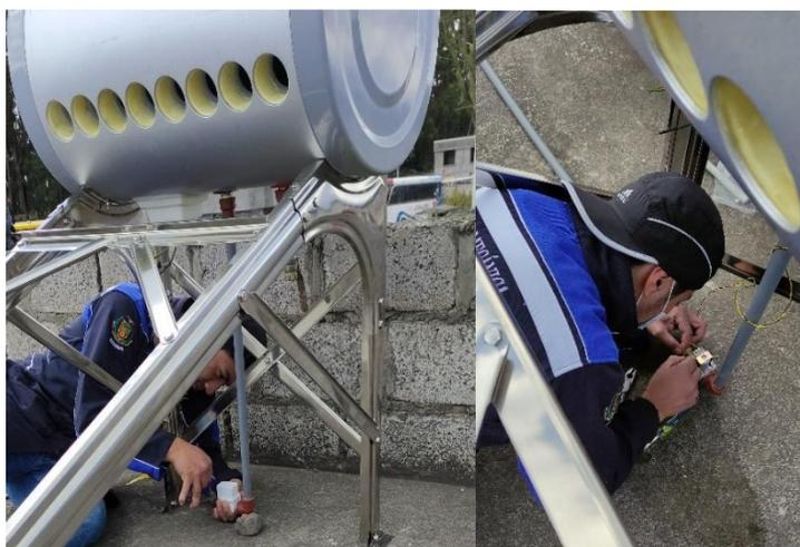
*Nota:* La fotografía muestra la conexión de la electroválvula entre la red de agua potable y la entrada de agua al termotanque.
