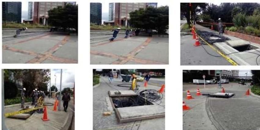
Nota. Una de las técnicas más tradicionales es halar la fibra óptica, al hacerlo tendrá fricción, esto se reduce con la utilización de lubricantes. Tomado de (Serna, 2018)
