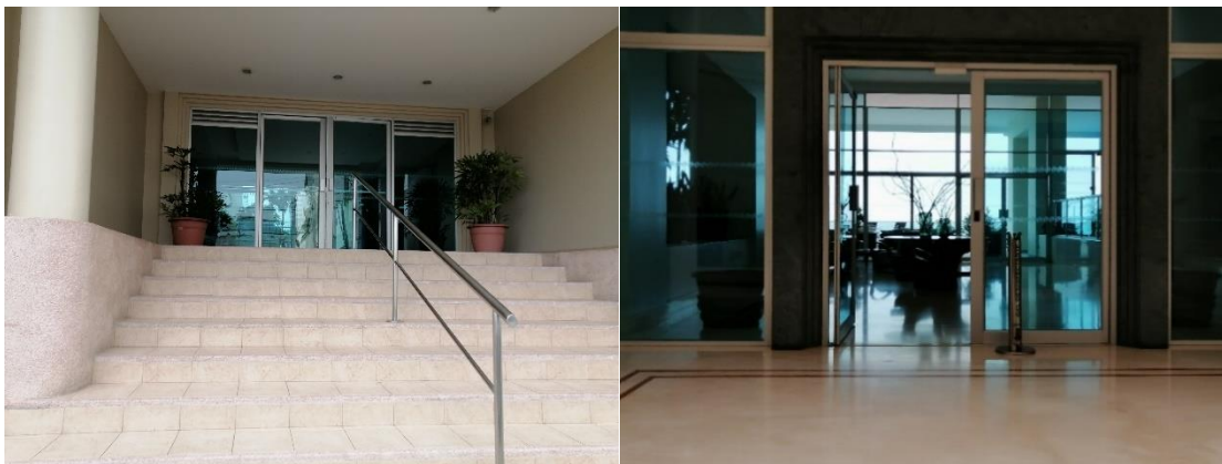
Accesos del edificio
