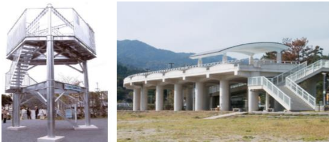
Torres de evacuación vertical
