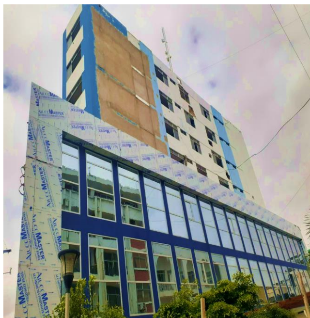
Edificio Empresa Pública Aguas de Manta (EPAM)
