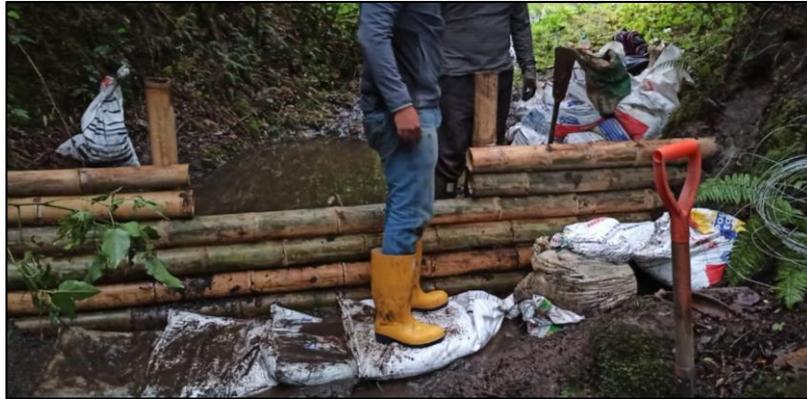
El resultado final de la construcción del dique se aprecia en la Figura 58. Adicionalmente se evidenció inmediatamente el funcionamiento del dique, como se aprecia en la Figura 59.
