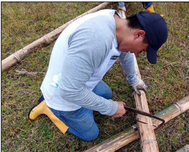
Una vez excavada la zanja y cortadas las cañas guaduas, se emplazó el dique de acuerdo a los esquemas de las Figuras 49 y 50, asegurando en las laderas un anclaje adecuado con el suelo de la zona, como se indica en la Figura 55, adicionalmente se amarró con alambre galvanizado las cañas de sentido longitudinal con las de sentido transversal, como se aprecia en la Figura 56.
