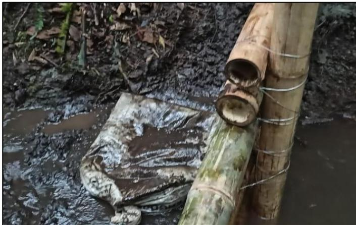
A continuación, se rellenó los costales con terrocemento, proporción 5:1 (tierra - cemento), los cuales se ubicaron aguas abajo, ya que conformaron el delantal del dique como se indica en la Figura 57.
