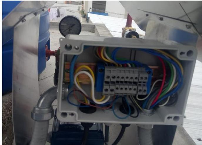
Finalmente, para terminar con la instalación del sistema, se realizó la calibración del presóstato, el cual fue fijado en el límite de los 40Psi máximos, ya que durante las pruebas realizadas se comprobó que dicho valor es el de uso normal, mientras que en caso de exceder dicho valor el Arduino actuaría conforme a lo programado.
