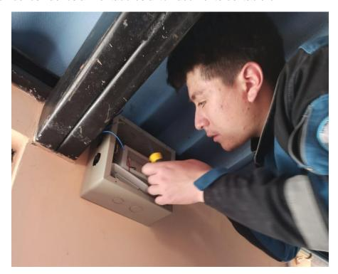
Nota. La figura representa la conexión de los nuevos cables conductores al tomacorriente y transformador que posee el tablero.
