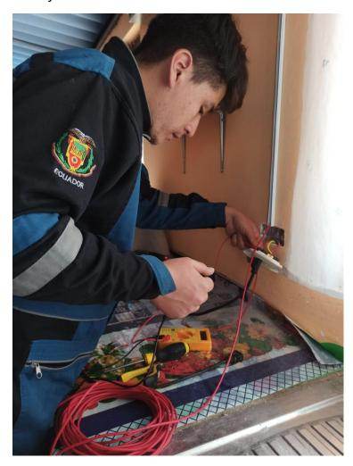
Nota. La figura representa el método para identificar la línea de fase y neutro en una instalación eléctrica.
