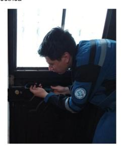
Nota. La figura representa la conexión de la cerradura eléctrica con los conductores provenientes del transformador y módulo relé.
