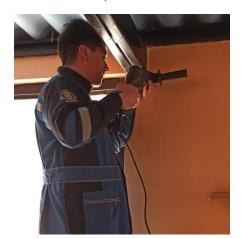
Nota. La figura representa el proceso de perforación utilizando un taladro para empotrar el tablero en la pared.
