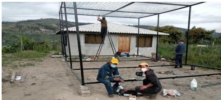
*Nota.* En la imagen se puede ver como se colocan los cables a través de los largueros de la cabina.
