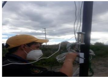
*Nota.* En la imagen se puede identificar al sistema de seguridad del circuito ya colocada y anclada a la estructura de la cabina.
