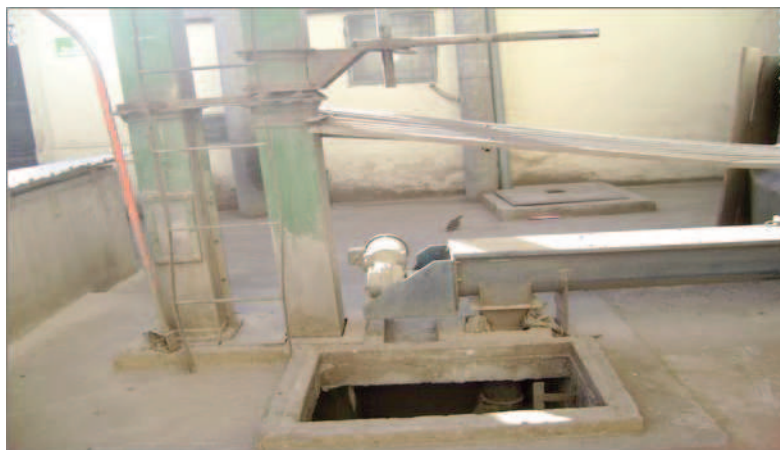
Figura 3.7: Espacio Confinado (Recepción del trigo)
