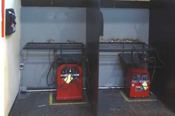
Fig. 13.- Estación de Soldadura Fuente: ITSA Bloque N°42
