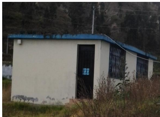
Figura 28 Cuarto de Máquinas
