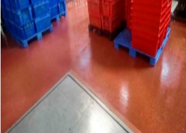
Caída al mismo nivel
