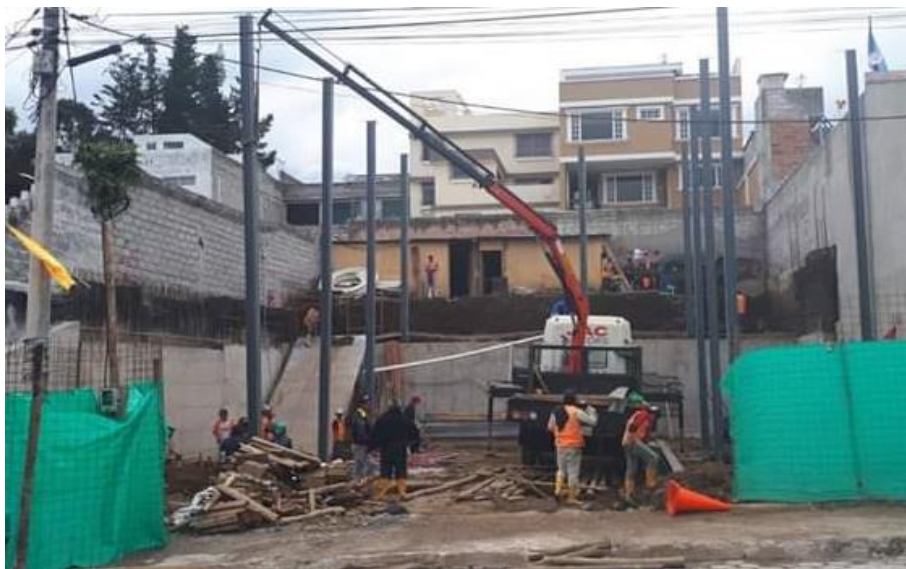
Figura 17. Proceso de Montaje
