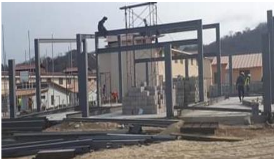
Figura 18. Proceso de Montaje
