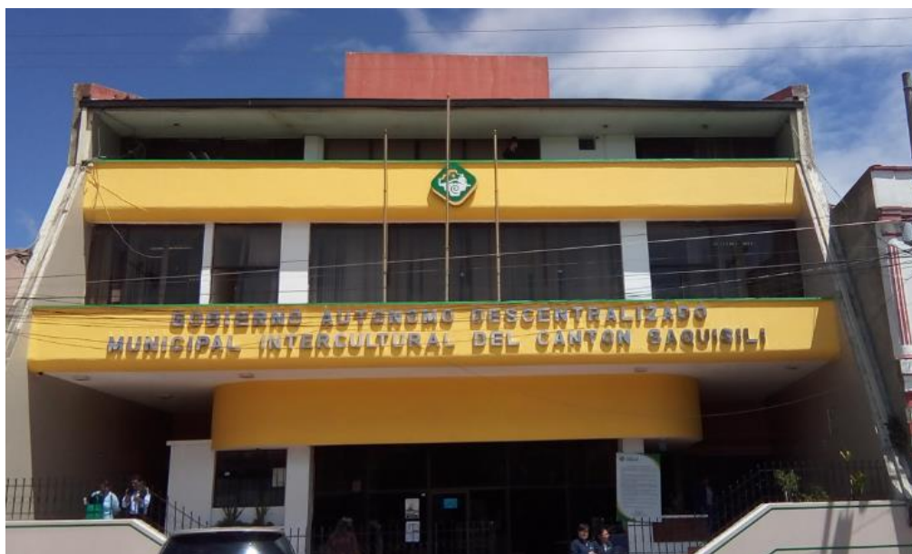
Figura 2. GADMIC-S Edificio Municipal
