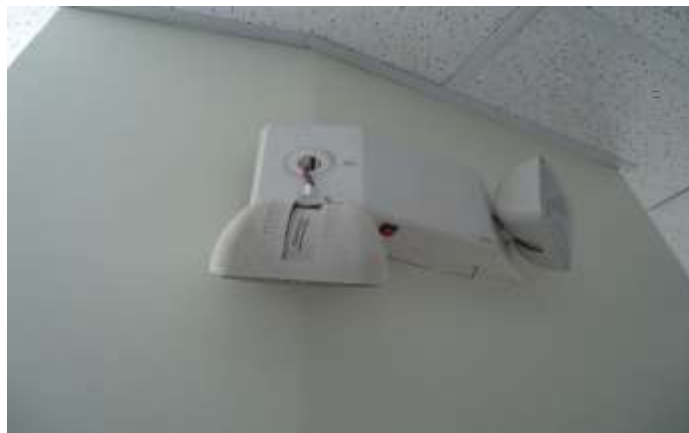
Figura 23. Luz de emergencia con lámpara averiada
