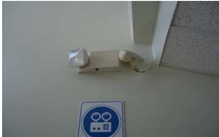
Figura 22. Luz de emergencia con lámpara mal dirigida
