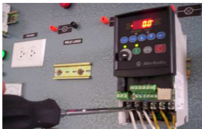
Figura 6.20 Manipulación en el bloque de Potencia
