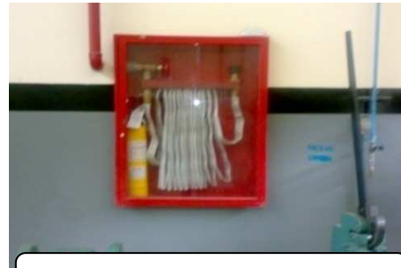
EXTINTOR DEL LABORATORIO
