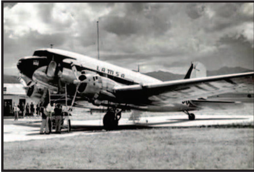
Figura 2.4 Tren de Aterrizaje Tipo Convencional
