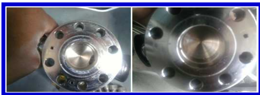
Figura 3.3.6.- Limpieza de corrosión (antes izq. y después der.)
